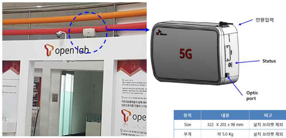
<그림 5-9> 밀리미터 5G Indoor 서비스 중계기 설치 사례
